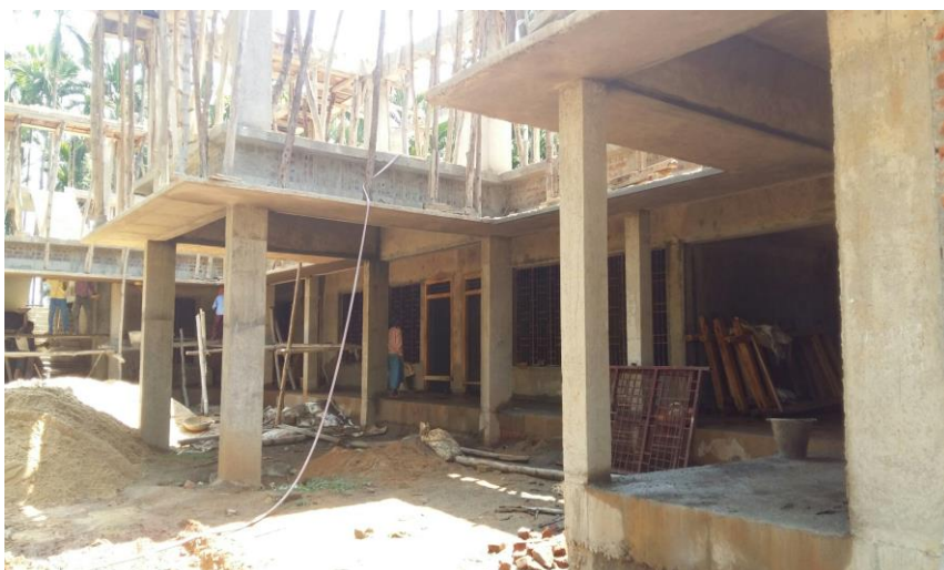
De school voor speciaal onderwijs in NR Pura in aanbouw
